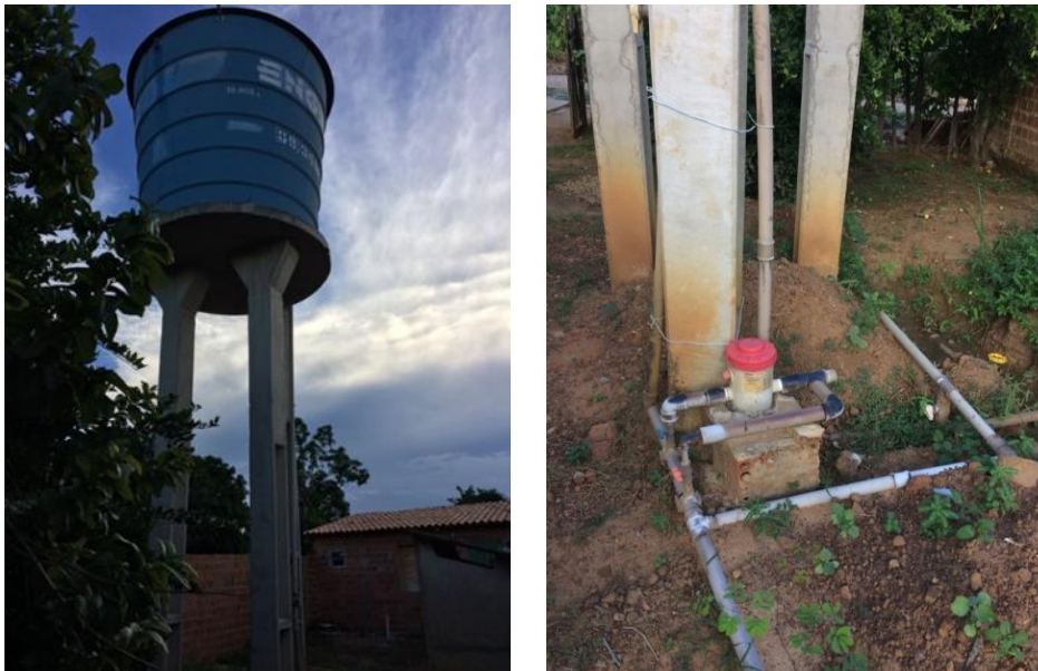
Figura 44 – Poço 4 (Rua Felix Paraguai) – Reservatório e clorador (inadequado para desinfecção de água para consumo humano).
