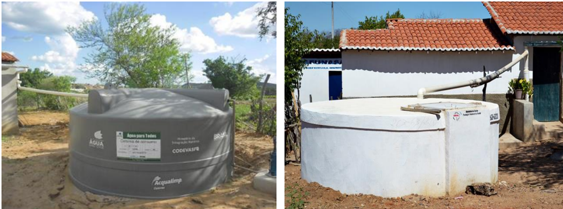
Figura 74 – Exemplos de cisterna em polietileno e em concreto
