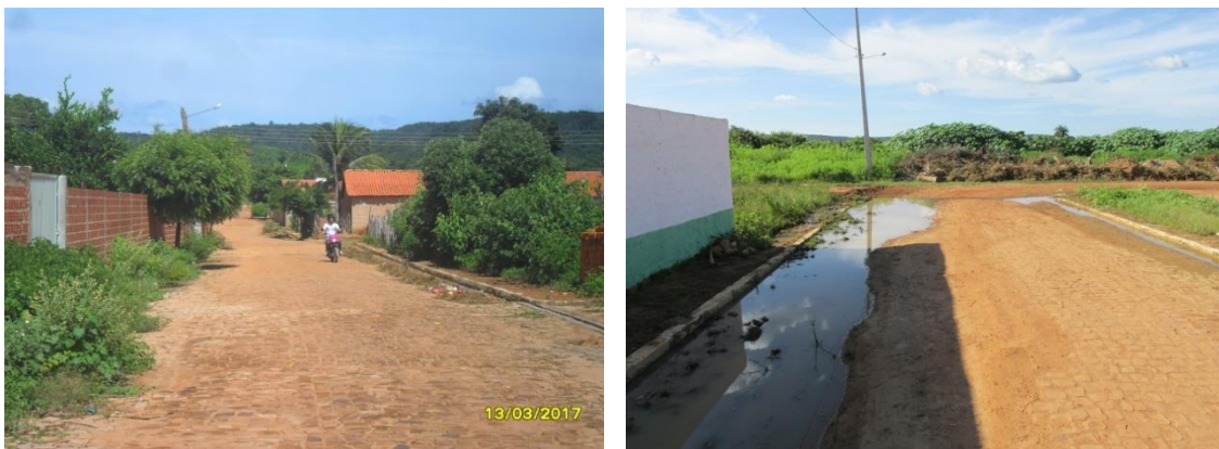
Figura 51 – Ausência de sistema de drenagem na sede (à esquerda) e área de empoçamento (à direita)
