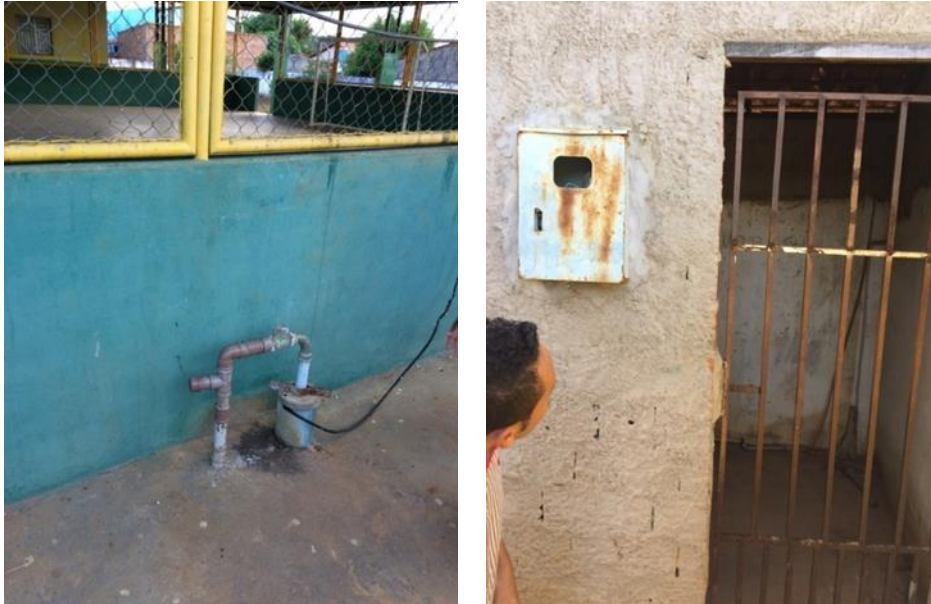
Figura 43 – Poço 4 (Rua Felix Paraguai) – Poço e abrigo do quadro de comando da bomba.
