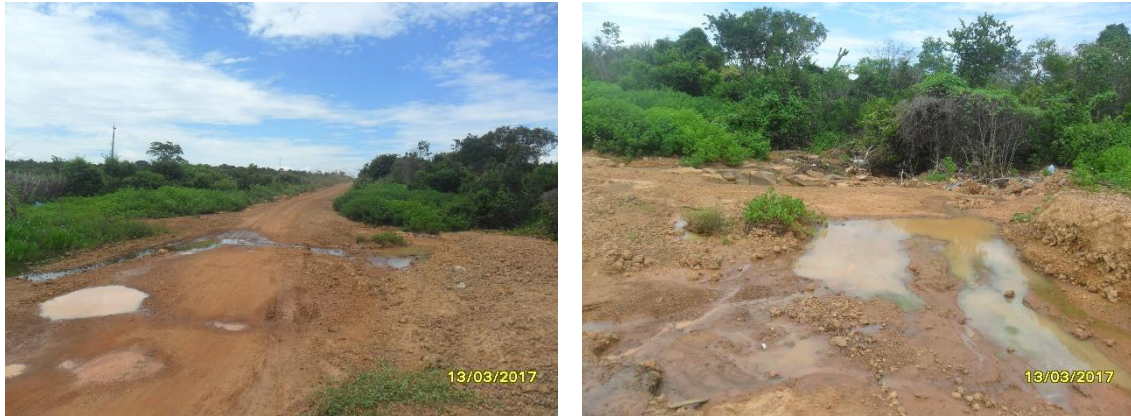
Figura 52 – Acúmulo de água nas vias de acesso a zona rural
