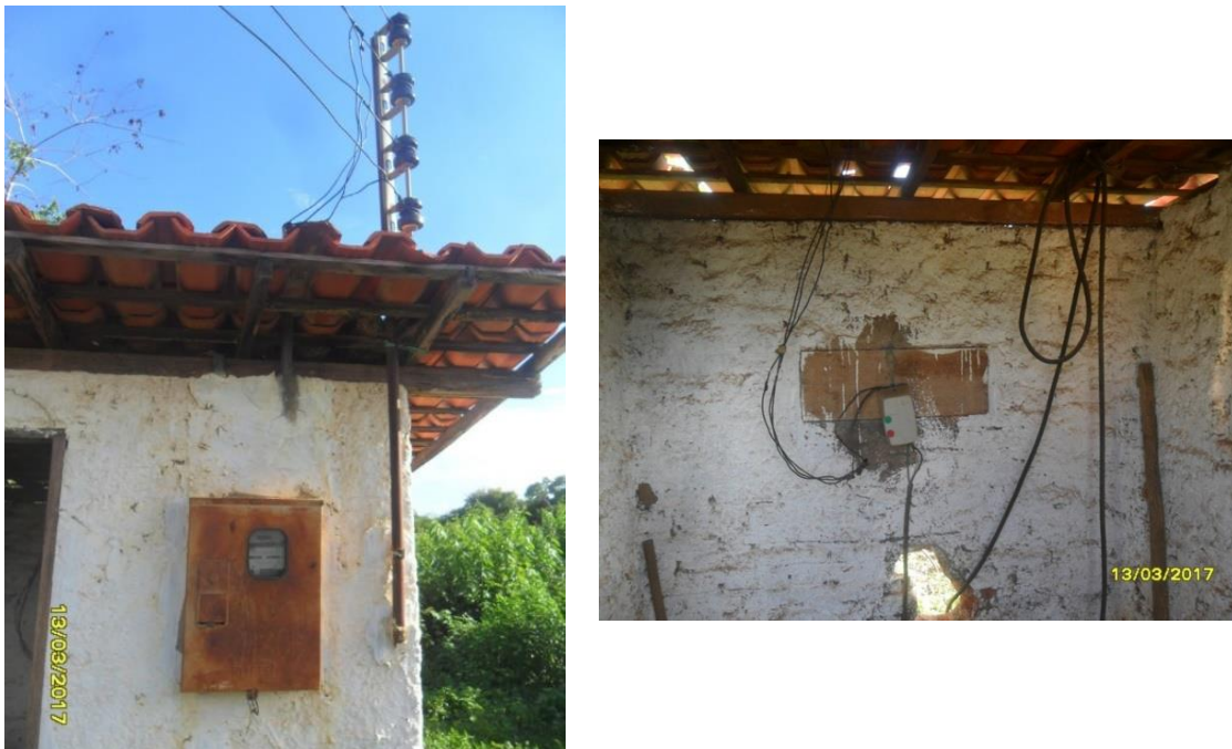
Figura 39 – Poço 1 (Av. Abel Cronemberger) – Quadro de energia e quadro de comando da bomba.
