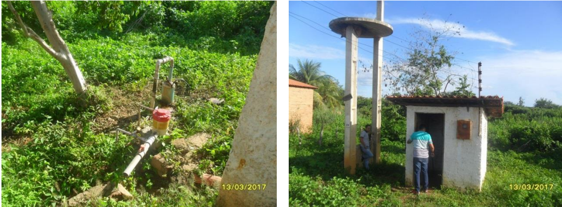
Figura 38 – Poço 1 (Av. Abel Cronemberger) – Poço e abrigo do quadro de comando da bomba.
