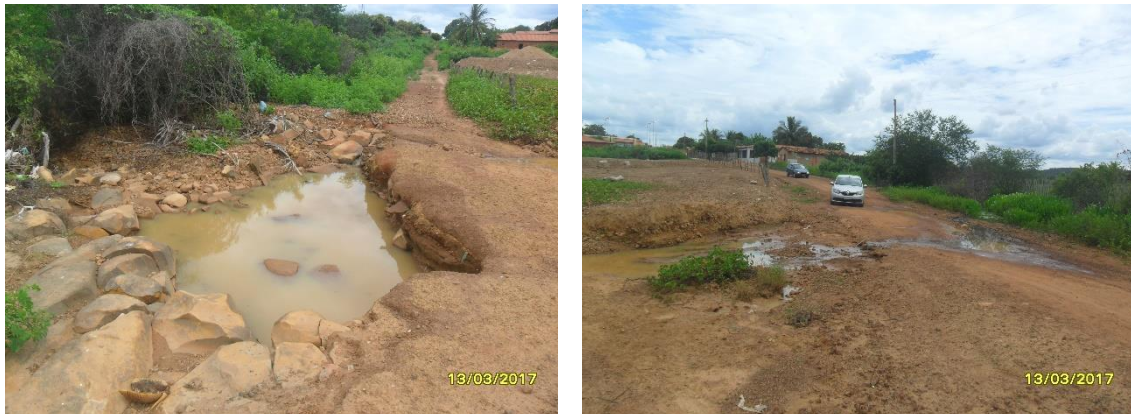
Figura 53 – Erosão e acúmulo de água nas vias de acesso a zona rural
