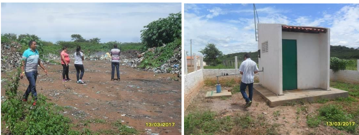
Figura 3 – Visitas técnicas às estruturas e equipamentos de saneamento no município
